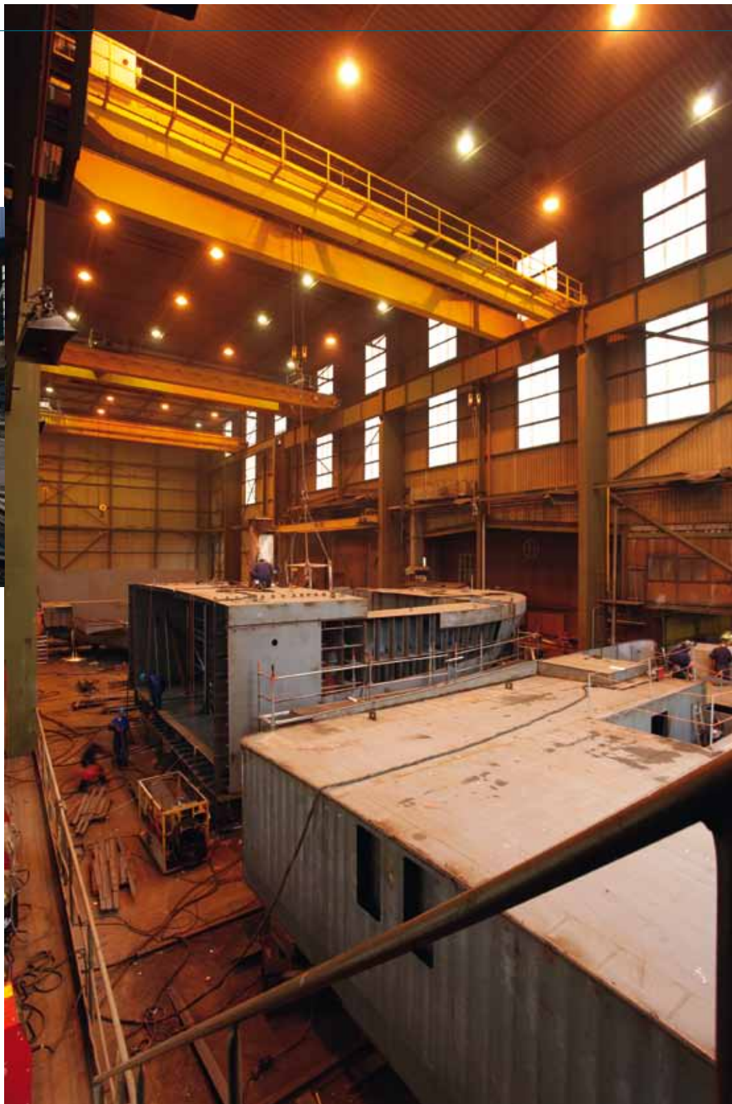
Die Sektionsbauhalle bietet Hebekapazitäten von 3 x 2 x 20 Tonnen und 1 x 10 Tonnen. De sectiebouwhal heeft een kraancapaciteit van 3 x 2 x 20 Ton en 1 x 10 Ton.
