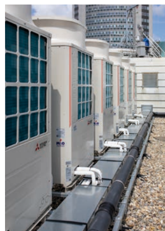
Renovatie 6 verdiepingen: 16 warmtepompen en 114 binnen-units, voor gasloos verwarmen en koelen kantoren
