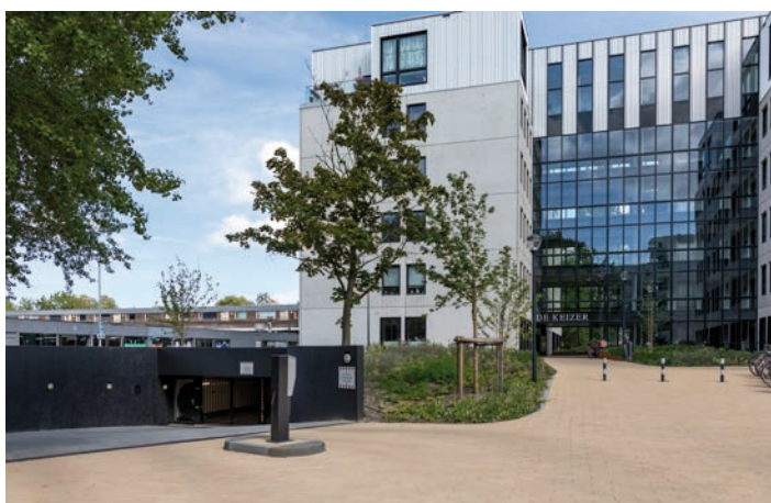
Transformatie bedrijfspand De Keijzer in Haarlem naar 113 gasloze appartementen
