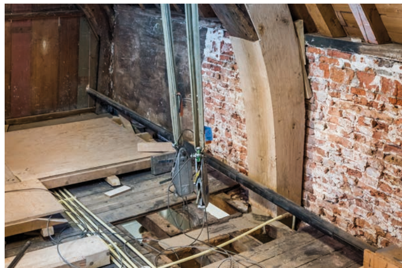
Houtrestauratie met epoxytechnieken
